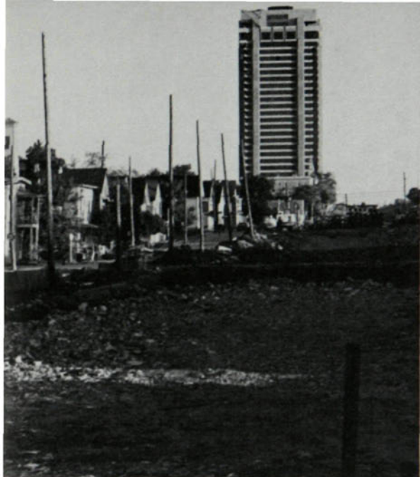
Le boulevard Maisonneuve en construction.
