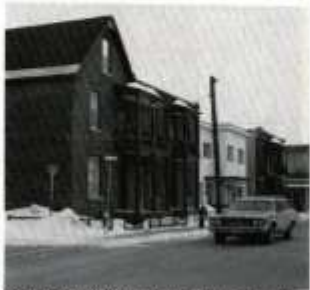
Groupe de maisons (rue Victoria) achetées depuis par la Caisse Populaire de Hull et remplacées par un condominium.
