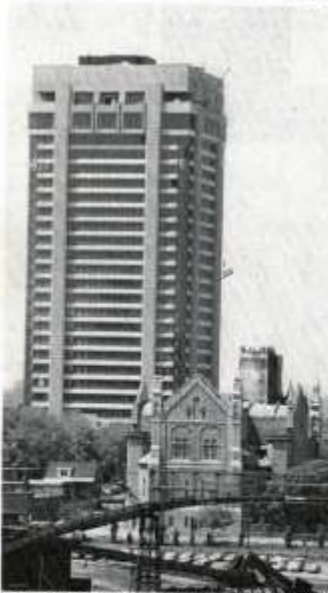
Place du Portage en construction et l'église Notre-Dame au lendemain de l'incendie.
