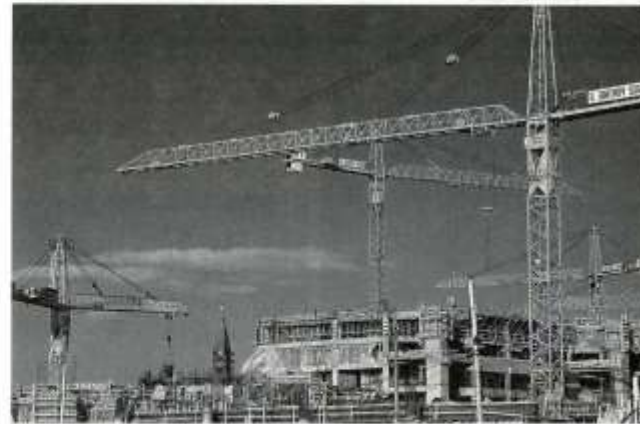
Et les démolitions continuent pour être suivies par la construction des tours fédérales.
