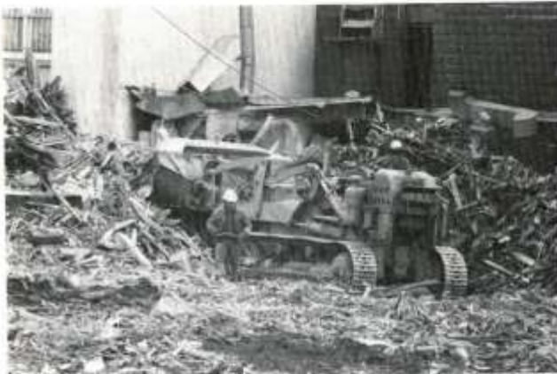
Et l'on continue de plus belle à démolir.
