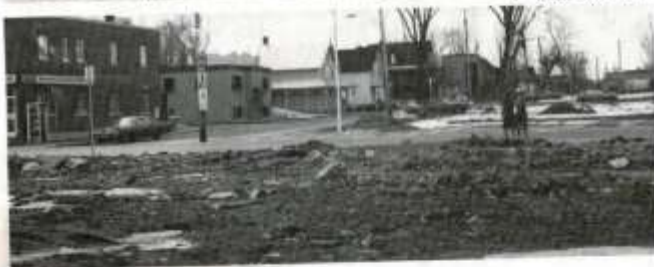
Les maisons de la rue Laramée sont rasées. ▼ (Photo: AGH/CCDI)
