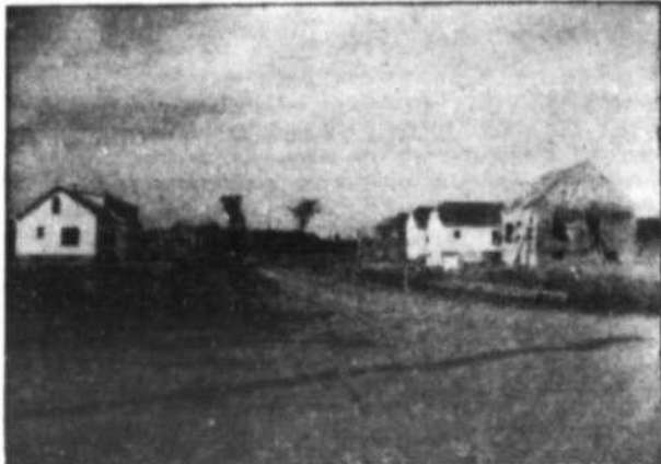
Les Chantiers St-Joseph de Granby ont construit 20 maisons.
