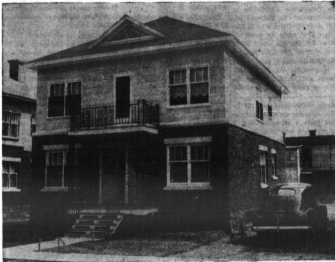
Maisons à deux logements construites par la Coopérative Ste-Thérèse de l'Enfant-Jésus, à Joliette.
